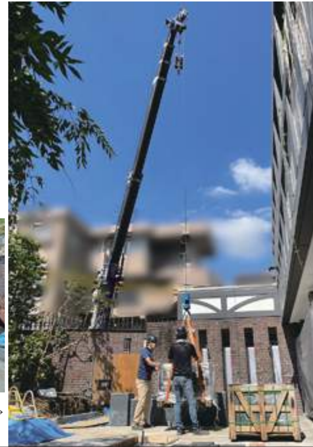
高いアームを誘導。安全第一に資材搬入→
